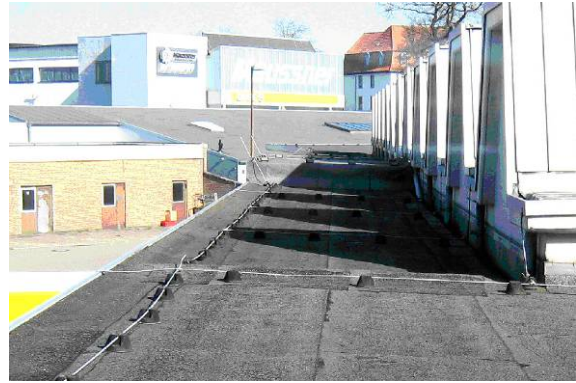
Teerdach des Hauptgebäudes mit geschlossenen Lüftungen (ohne Befunde)
