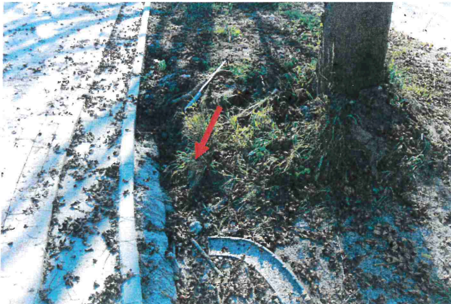
Foto 2: Blick von Norden auf den Kronentraufbereich von Baum Nr. 1. Oberflächennah ist der Feinwurzelhorizont mit der Grasnarbe fast vollständig abgetragen bzw. zerstört worden. Der untere Pfeil zeigt die Kante der Auskofferung für die Herstellung des Fuß- und Radweges
