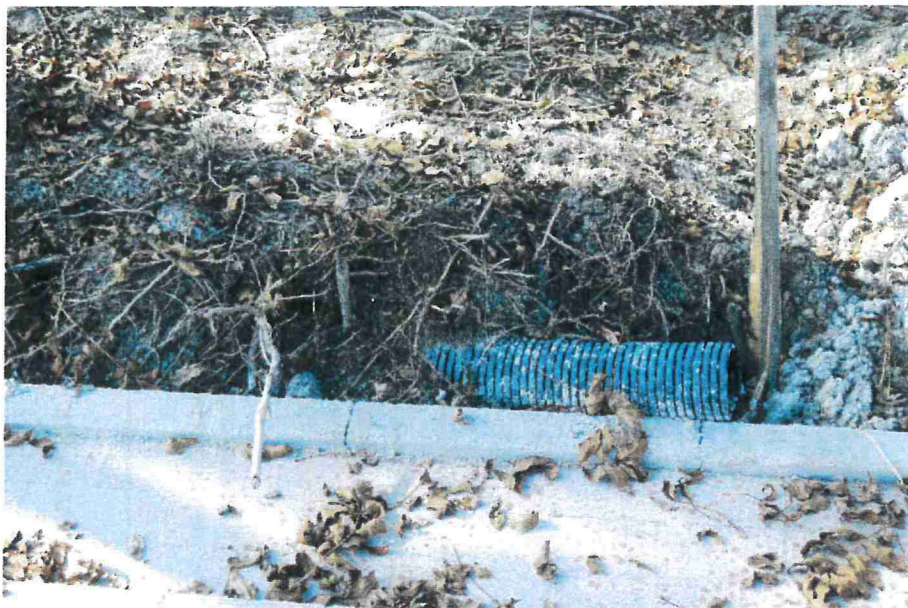
Foto 6: Wurzelschäden zwischen den Bäumen Nr. 2 und 3 infolge Wegebau und Drainageverlegung
